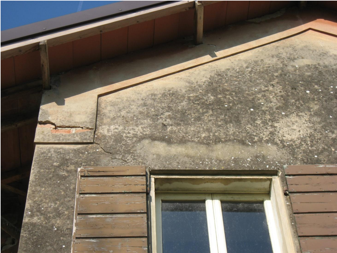
Fe 27: lesione diagonale nel maschio
