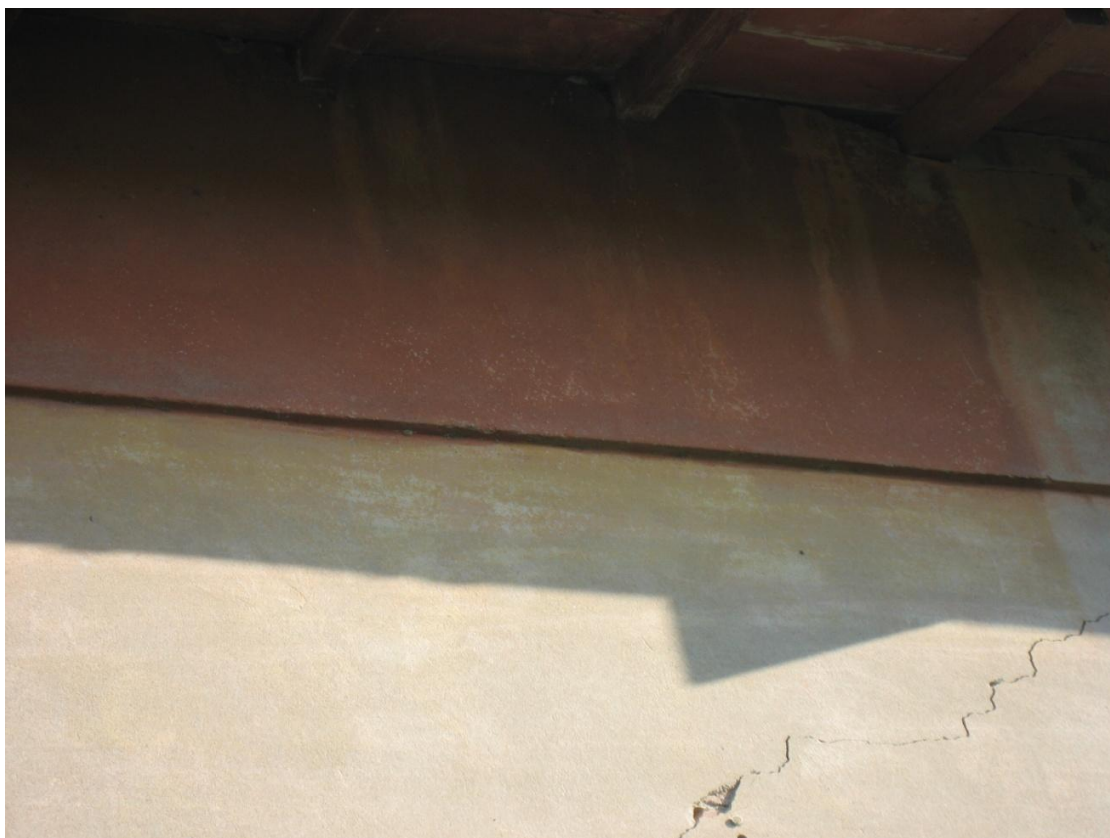
Fe 3 Fe 4: lesione diagonale nel maschio
