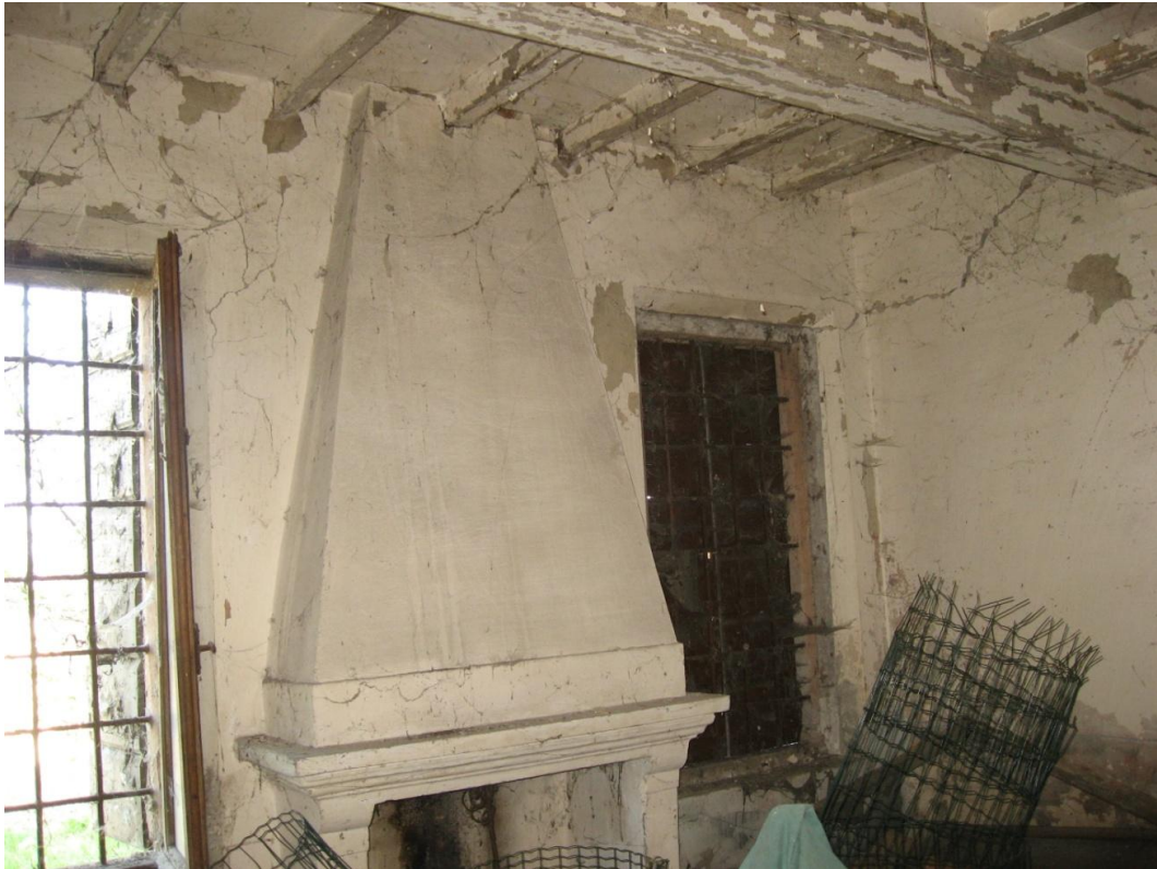
Fe 14 Fe 17 Fe 18: lesione diagonale nel maschio con formazione di piccolo cuneo dislocato con il maschio in angolo
