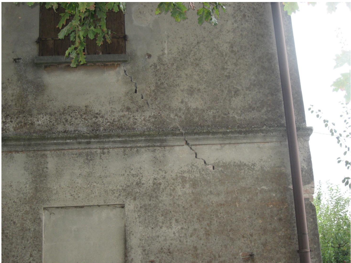
Fe 14 Fe 15: lesione diagonale nel maschio
