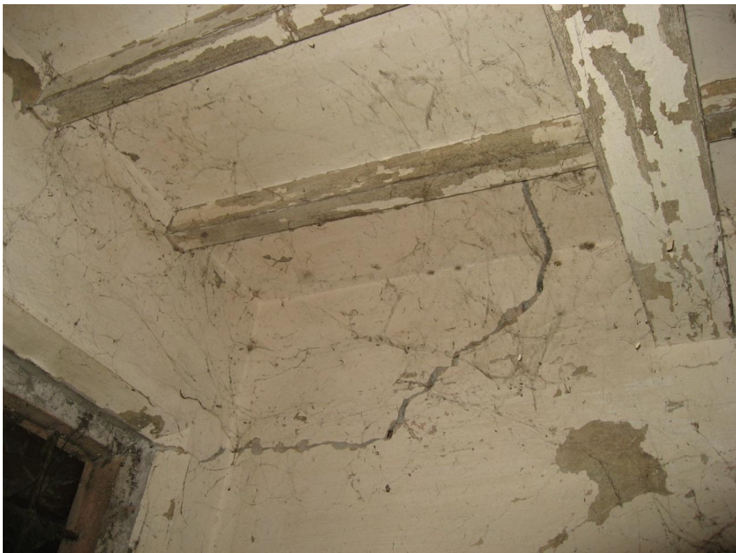
Fe 14 e Fe 17: lesione diagonale nel maschio con formazione di piccolo cuneo dislocato con il maschio in angolo
