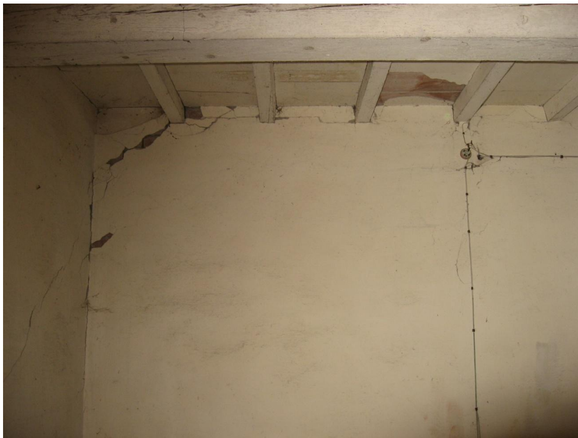
Fi 9 vista dall'altra stanza: lesione diagonale nel maschio
