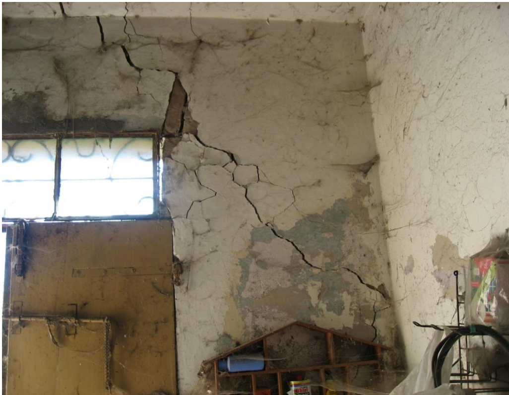
Fe 7 Fe 8: lesione diagonale nel maschio interessante anche la piattabanda
