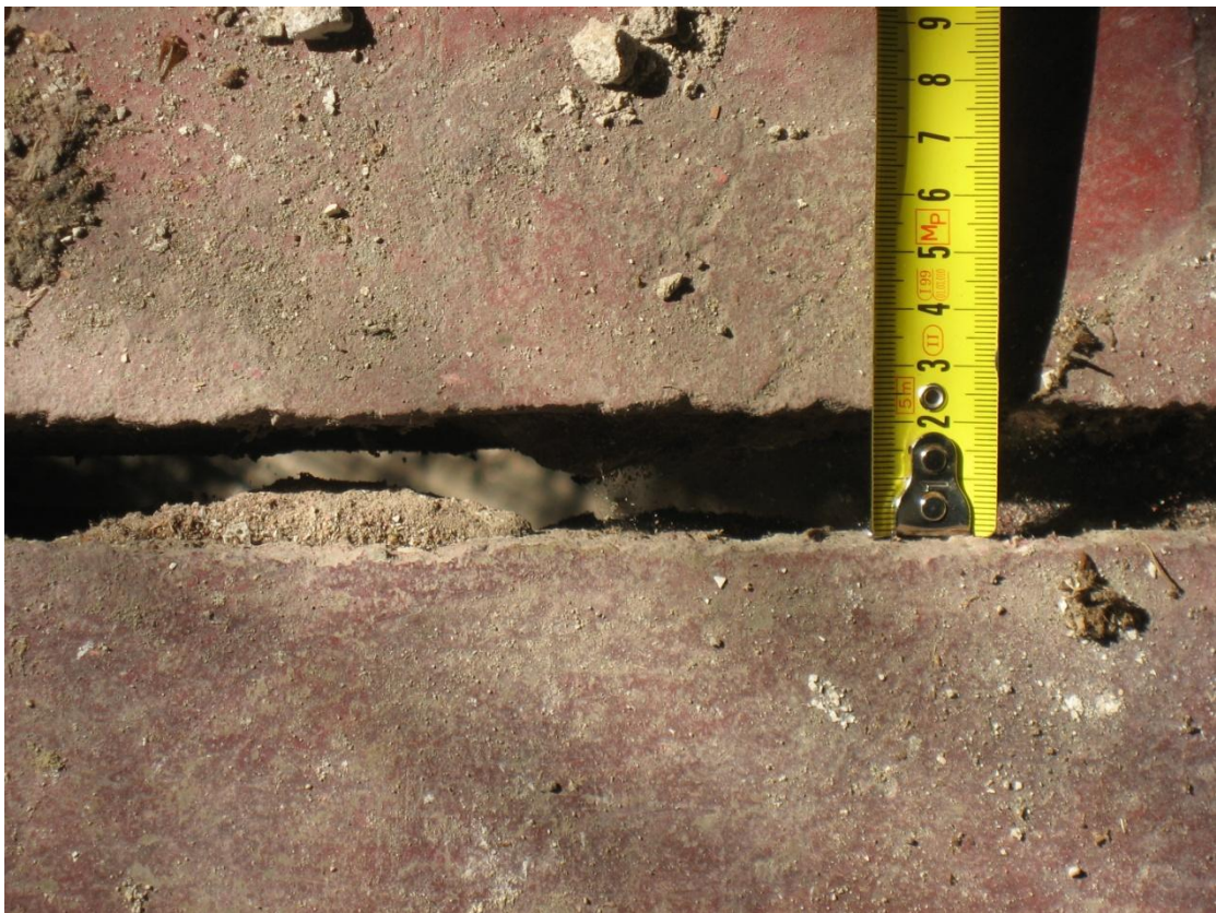
Particolare della foto precedente: da notare che si vede il piano sottostante
