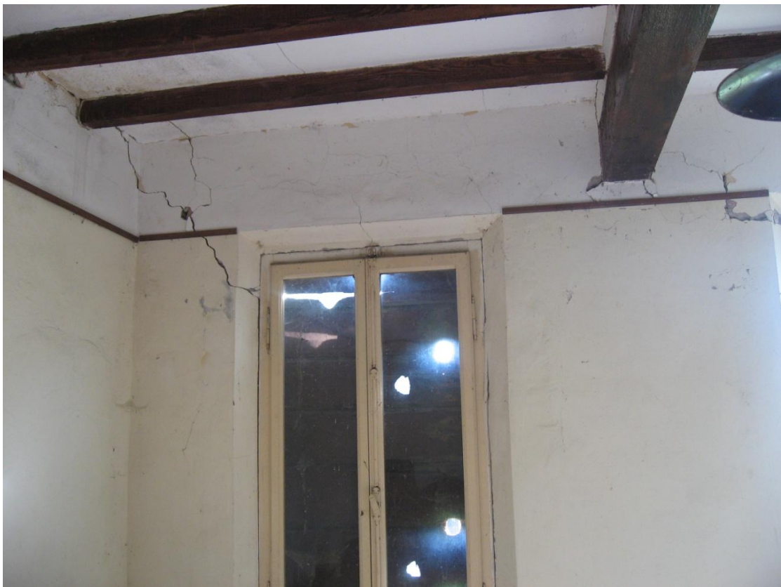
Fe 12: lesione diagonale nel maschio interessante anche il maschio in angolo; si nota il martellamento della trave
