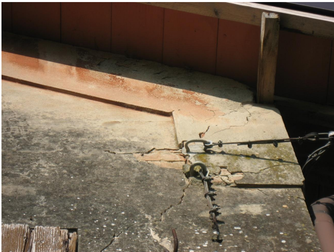
Fe 12 Fe 13: lesione diagonale nel maschio
