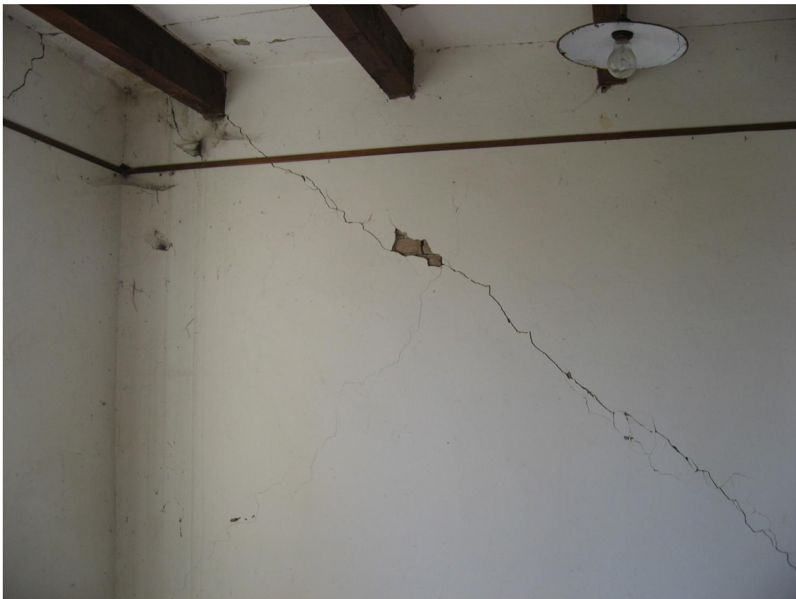
Fe 3: lesione diagonale nel maschio
