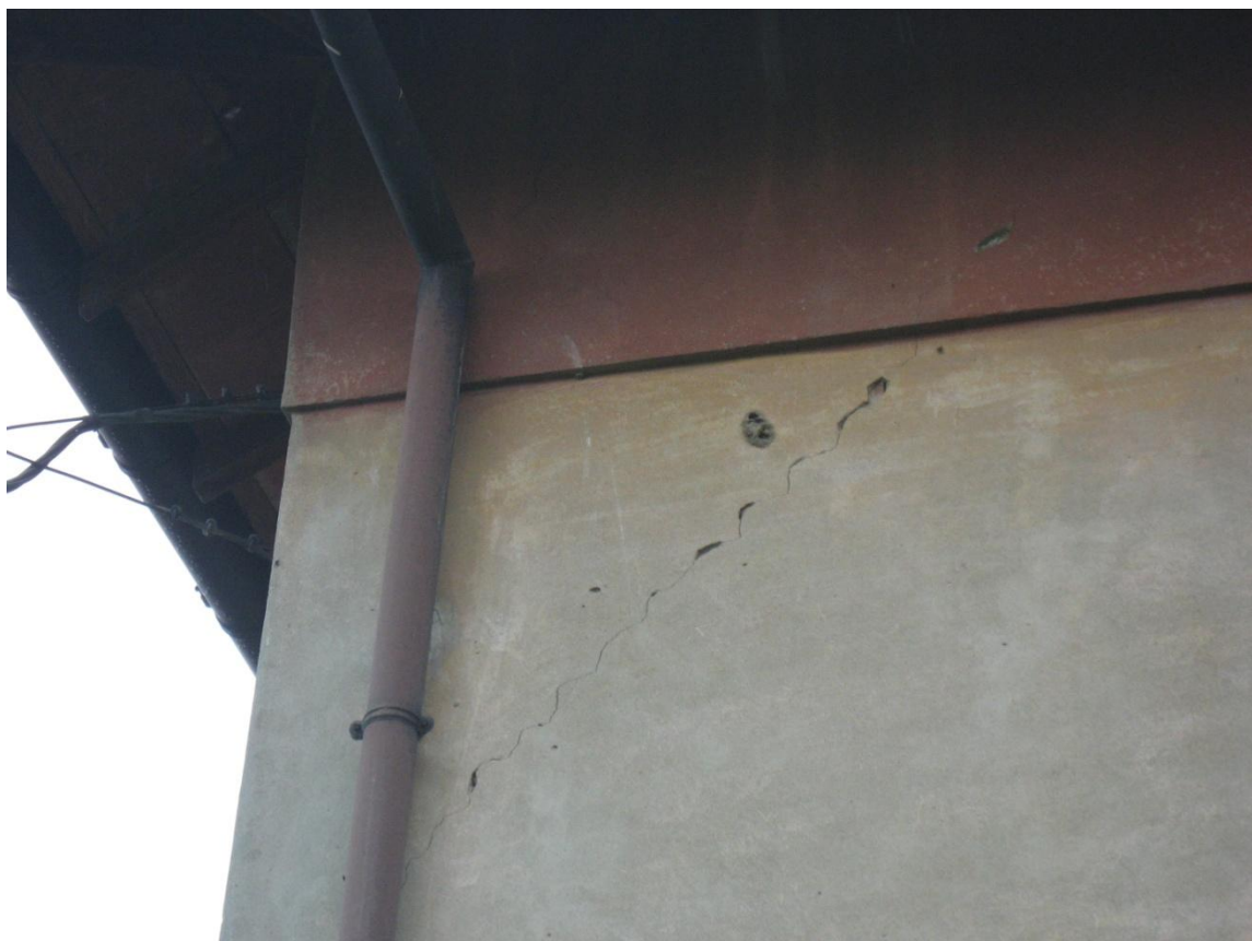
Fe 1 Fe 2: lesione diagonale nel maschio
