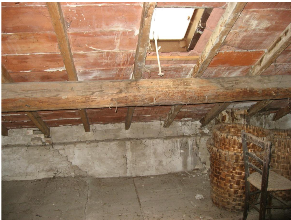
Fe 25 Fe 26: lesioni diagonali nel maschio
