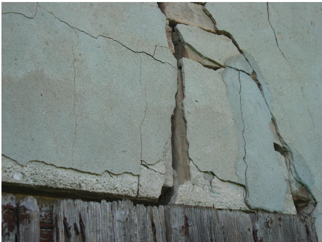
Fe 19: particolare della rottura della piattabanda
