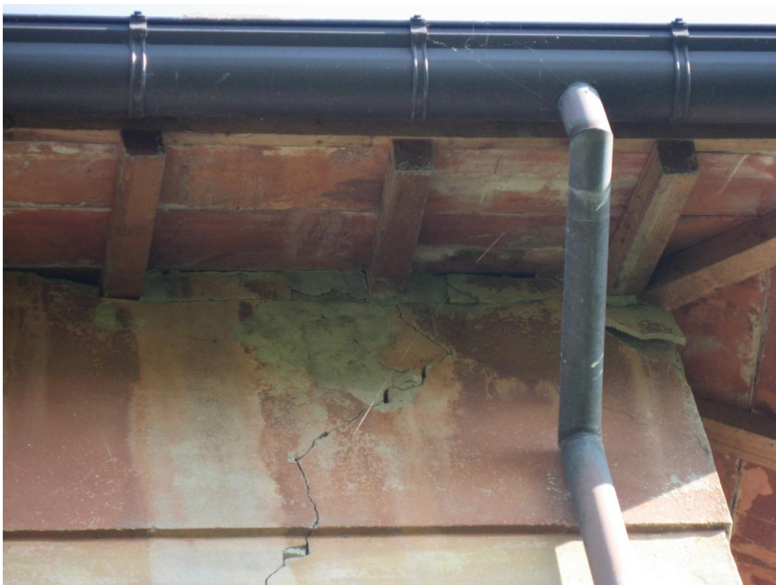
Fe 4: lesione diagonale nel maschio
