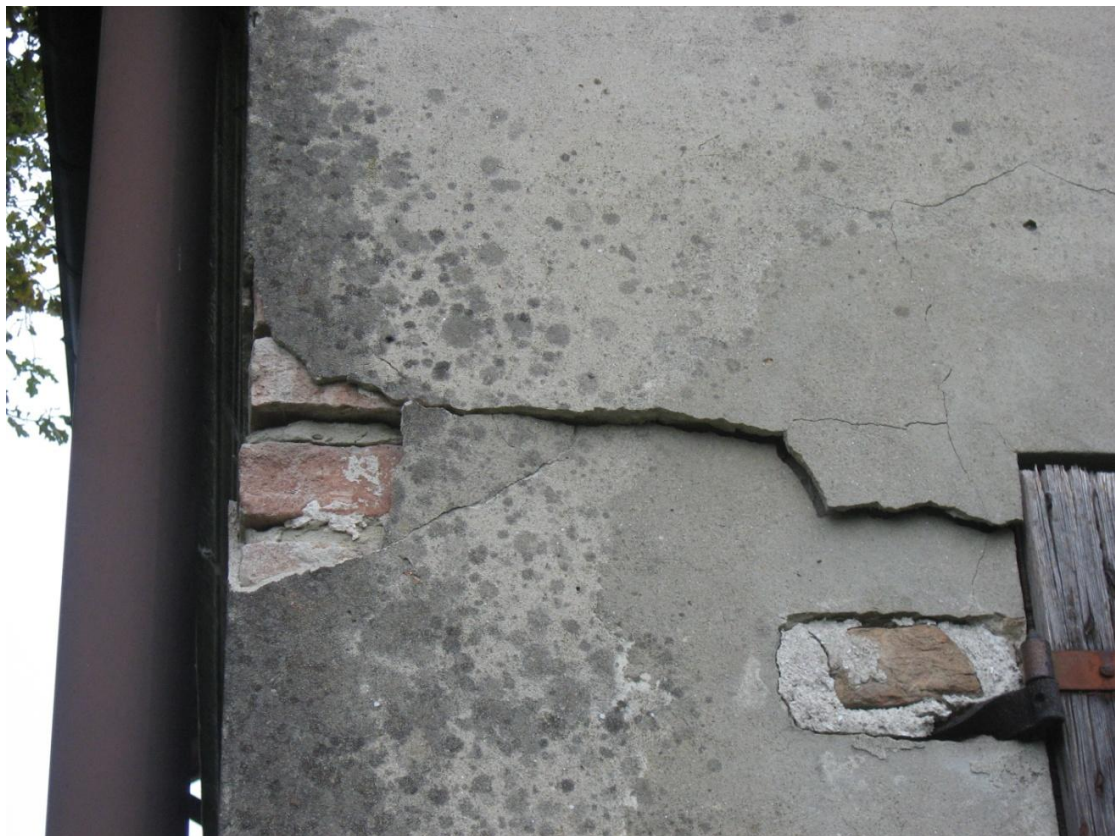
Fe 17: creazione di piccolo cuneo dislocato con il maschio in angolo
