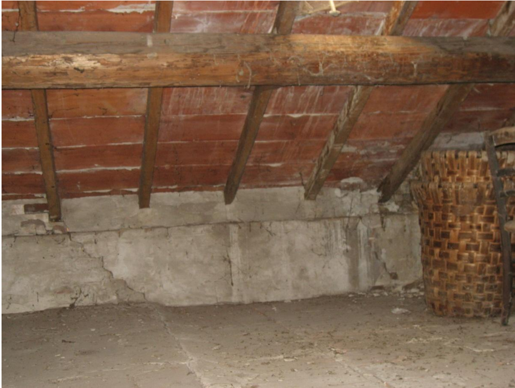
Fe 25 Fe 26: lesioni diagonali nel maschio
