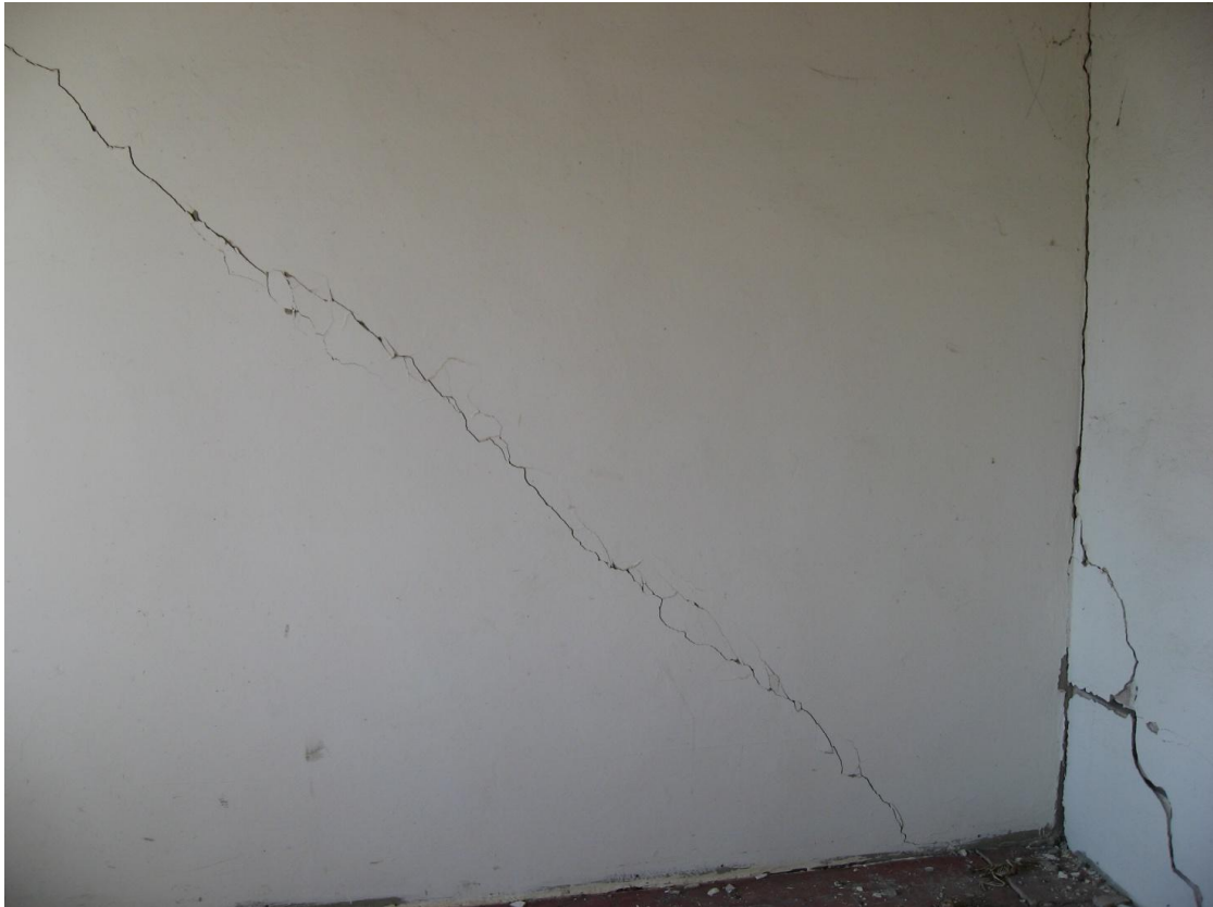
Fe 3: lesione diagonale nel maschio
