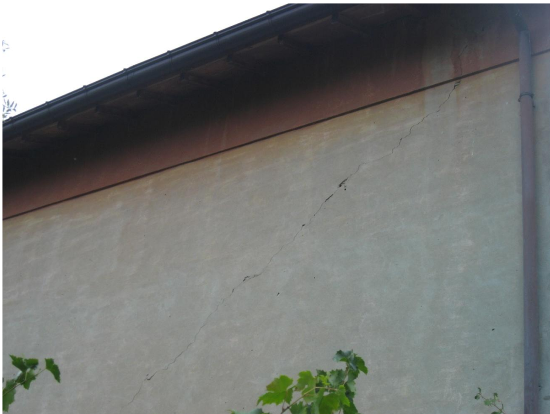
Fe 3 Fe 4: lesione diagonale nel maschio
