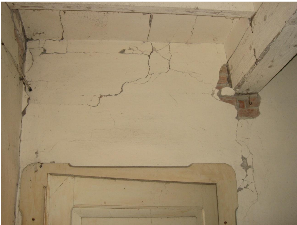
Fi 9 vista dall'altra stanza: lesione diagonale nel maschio
