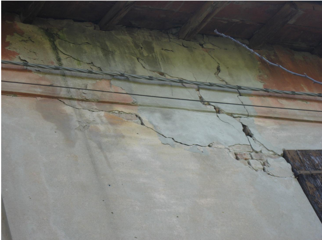
Fe 21 Fe 25: lesione diagonale nel maschio
